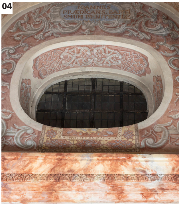
Kościół pw. św. Józefa Oblubieńca NMP we Wschowie fragment ściany północnej.
