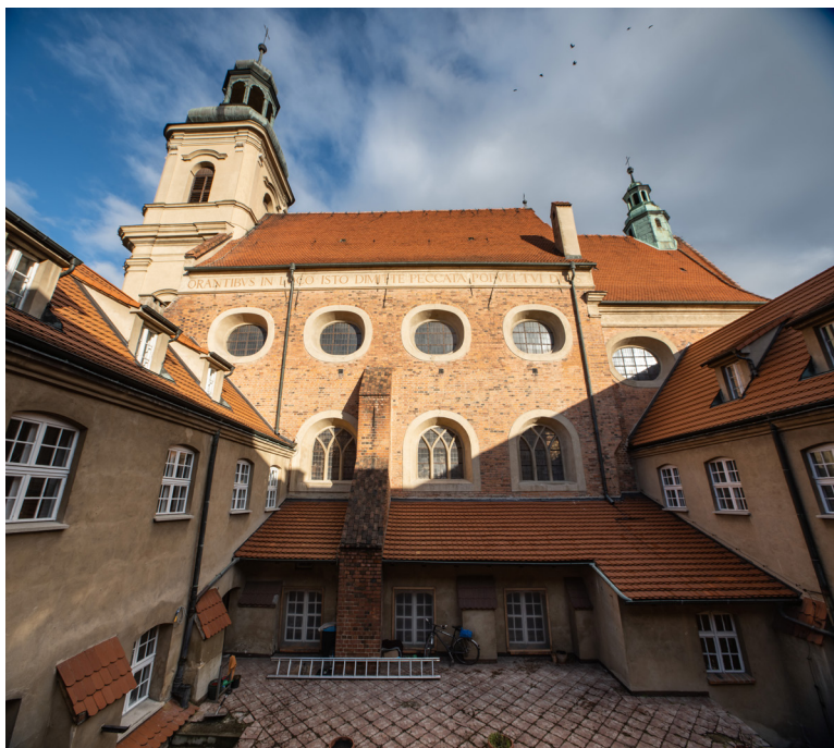
Kościół pw. św. Józefa Oblubieńca NMP we Wschowie elewacja południowa.
