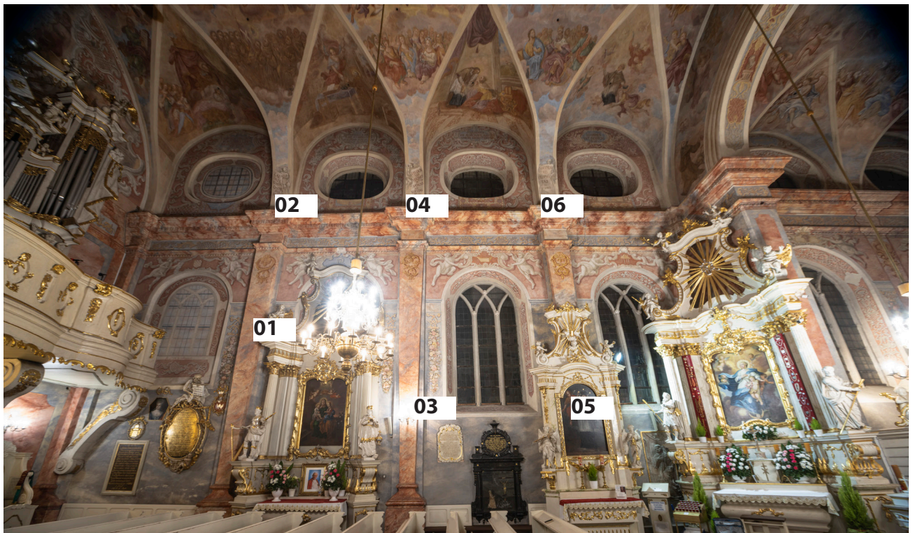
Kościół pw. św. Józefa Oblubieńca NMP we Wschowie ściana północna.
