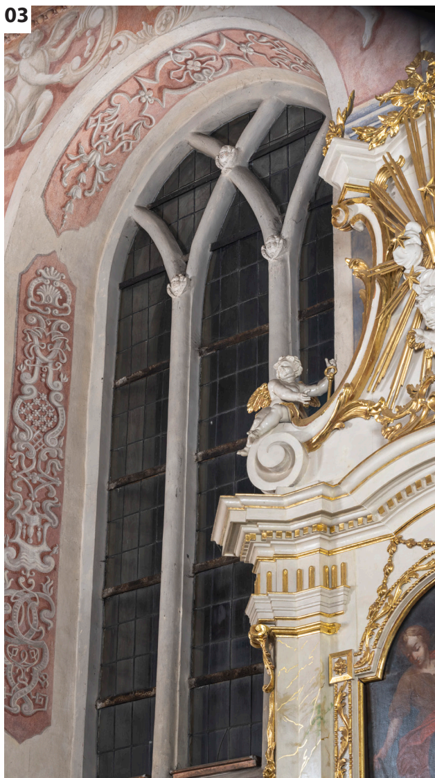
Kościół pw. św. Józefa Oblubieńca NMP we Wschowie ściana północna, fragment.
