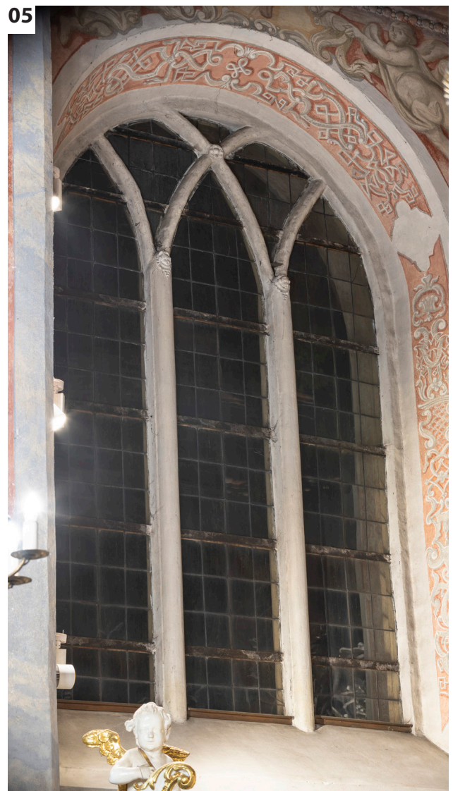
Kościół pw. św. Józefa Oblubieńca NMP we Wschowie ściana północna, fragment.
