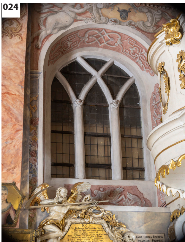
Kościół pw. św. Józefa Oblubieńca NMP we Wschowie fragment ściany południowej.
