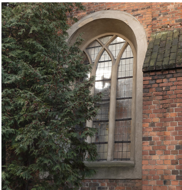
Cztery dolne kwatery okna 05 z próbnym nieinwazyjnym szkleniem dodatkowym
